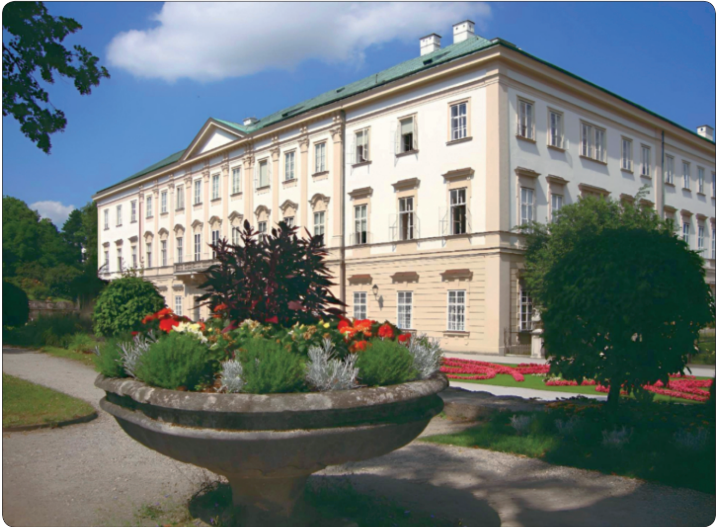
Blick auf die Außenfassade am Westtrakt des Gebäudes, von der Bastei des Mirabellgartens aus gesehen.
