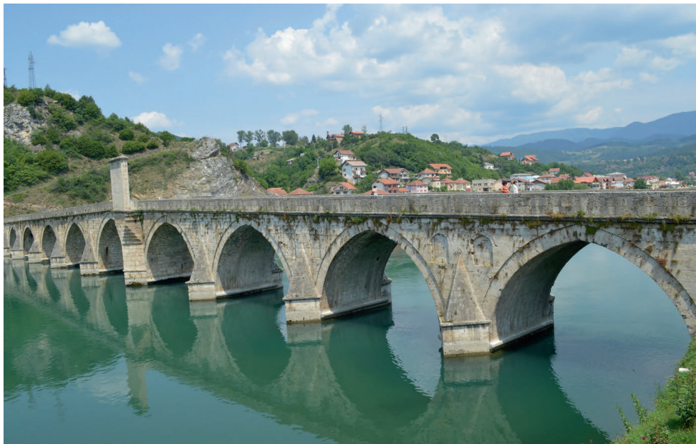
Abb.1 Osmanische Brücke über die Drina in Bosnien
