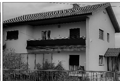
Abb. 2: Einfamilienhaus der 60-er Jahre © office WST
