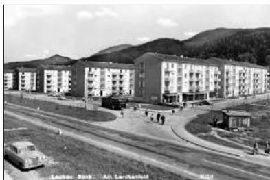
Abb. 1: Leoben Lerchenfeld, Geschoßwohnbau der 50-er Jahre
